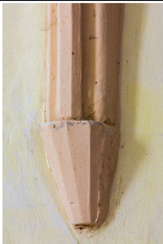
Čelní pohled na jihozápadní konzolu presbytáře. Foto: Marta Pavlíková 2019.
