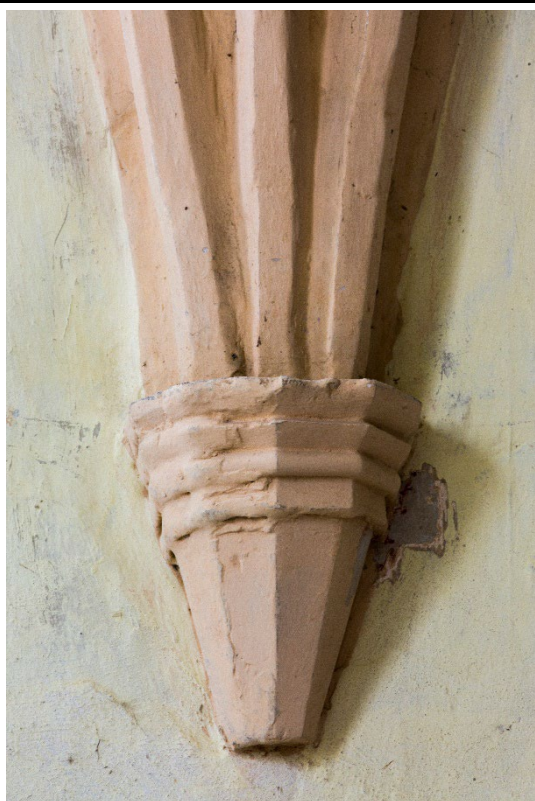
Čelní pohled na jižní konzolu presbytáře. Foto: Marta Pavlíková 2019.
