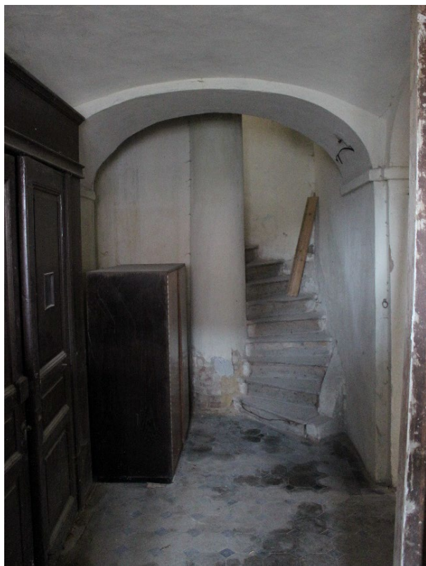
Pohled od jihu na severní stranu podkruchtí s nástupem na točité schodiště. Foto: Jaroslav Skopec 2013.
