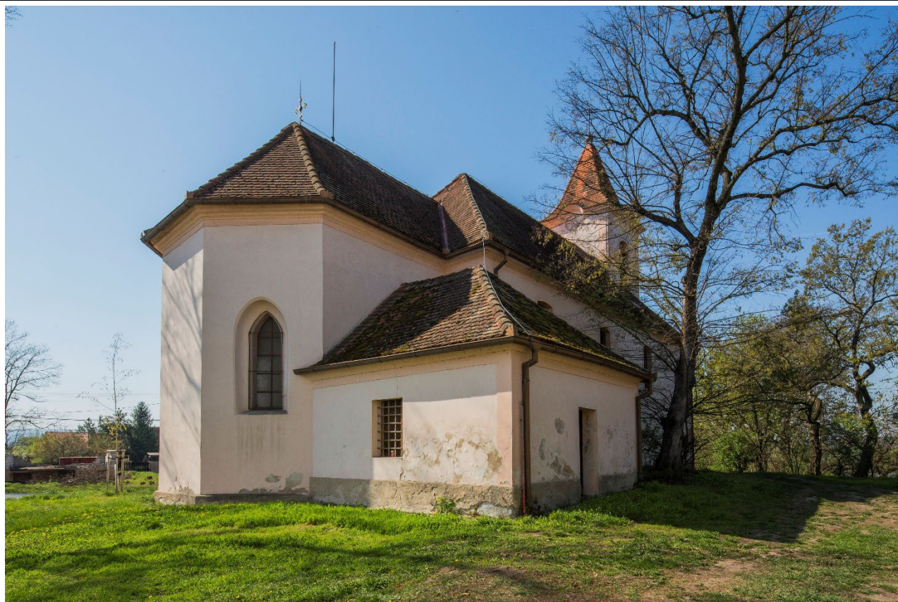
Celkový pohled od severovýchodu. Foto: Marta Pavlíková 2019.
