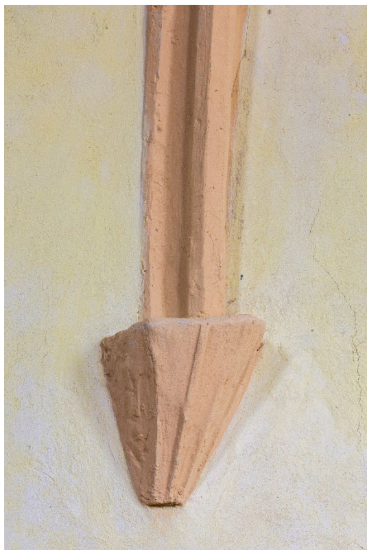
Čelní pohled na severozápadní konzolu presbytáře. Foto: Marta Pavlíková 2019.
