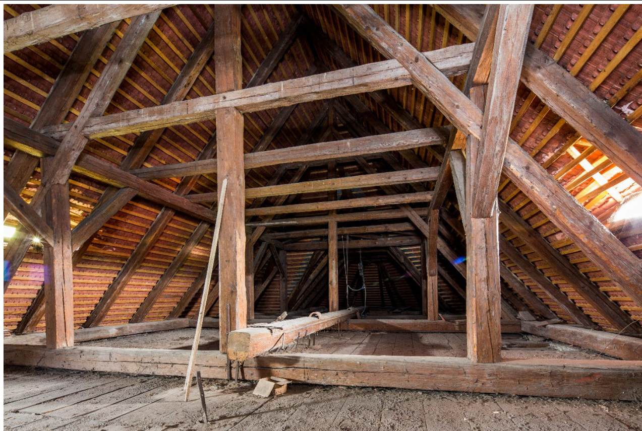
Krov nad lodí v pohledu od jihozápadu. Foto: Marta Pavlíková 2019.
