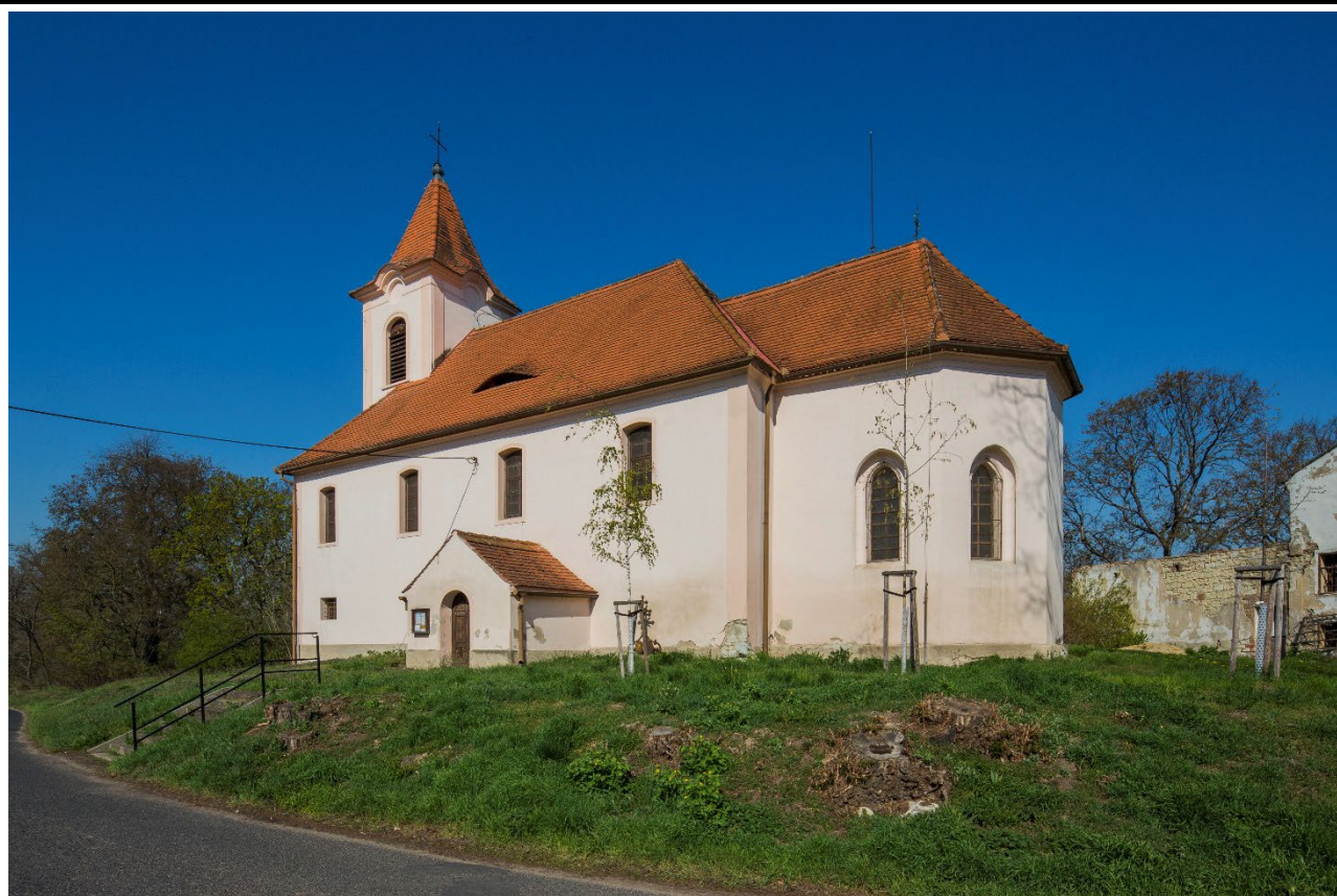
Celkový pohled od jihovýchodu. Foto: Marta Pavlíková 2019.
