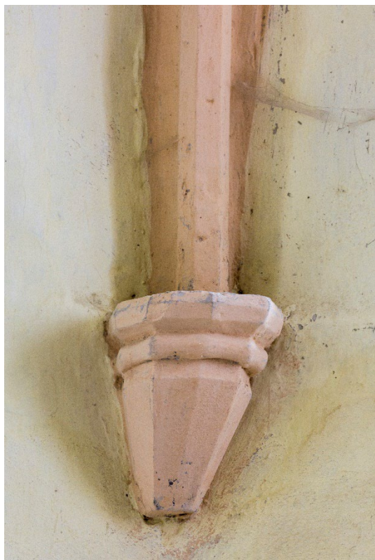
Čelní pohled na východojihovýchodní konzolu presbytáře. Foto: Marta Pavlíková 2019.
