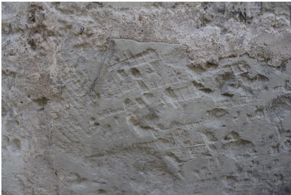
Detail stop po opravování plošinou s plochými zuby na kvádrech menzy hlavního oltáře. Foto: Jaroslav Skopec 2013.
