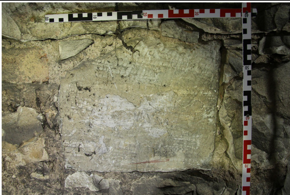
Detail prvku druhotně užitého ve zdivu nad vítězným obloukem se zřetelnými stopami po opracování plošinou s plochými zuby. Foto: Jaroslav Skopec 2019.
